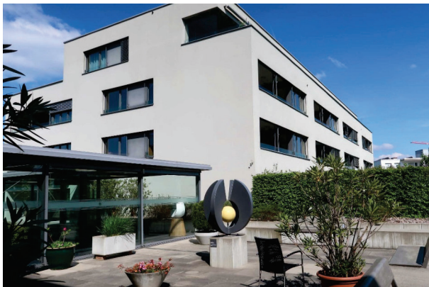
Wohnhaus an der Hofwiesenstrasse 10
