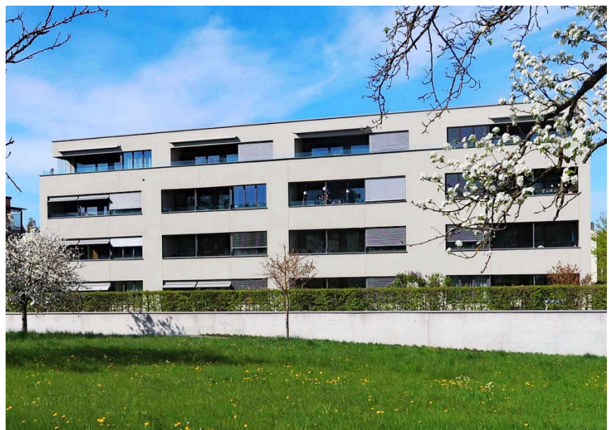
Wohnhaus an der Hofwiesenstrasse 10
