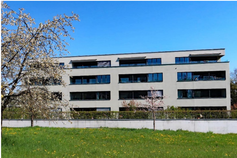
Wohnhaus Hofwiesen- strasse 10
