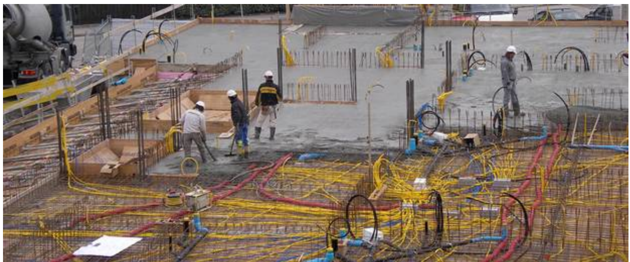
Bodenplatte des ersten Wohngeschosses, Februar 2011
